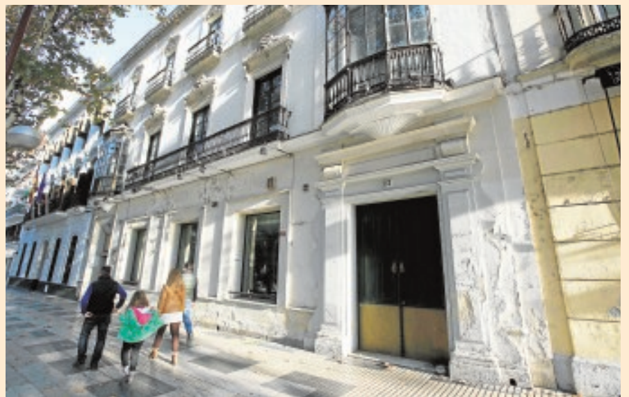
Reyes Católicos 23. El inmueble adquirido por la Real Maestranza de Caballería se transformará en un hotel
